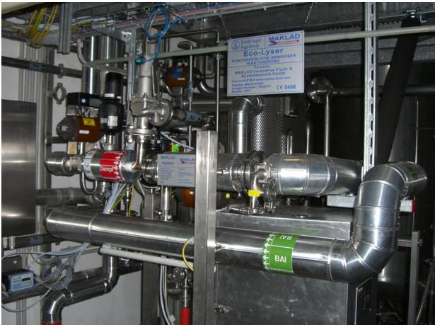
Die Innovation steckt im Herzstück der Anlage, dem MAKLAD INJEKTOR, der für die Erhitzung des Abwassers auf Inaktivierungstemperatur und die Zell-Desintegration verantwortlich ist.
